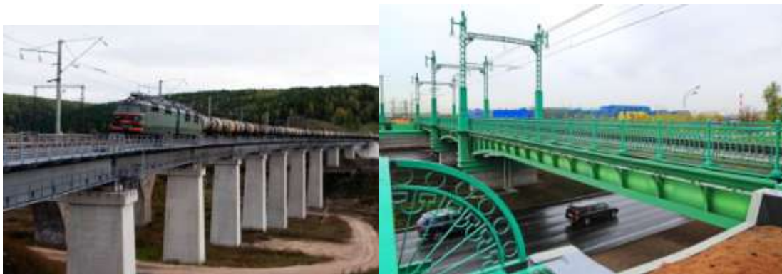
Рис. Путепровод, эстакада
