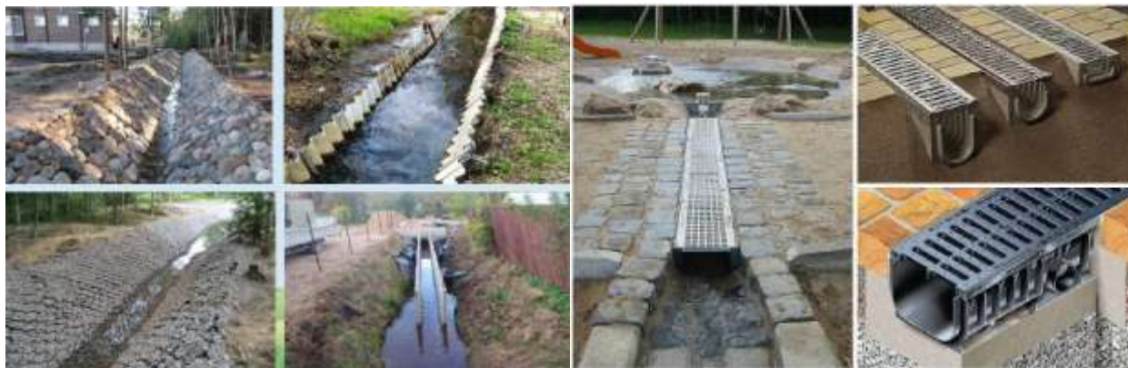
Рис. Открытые водоотводящие устройства
