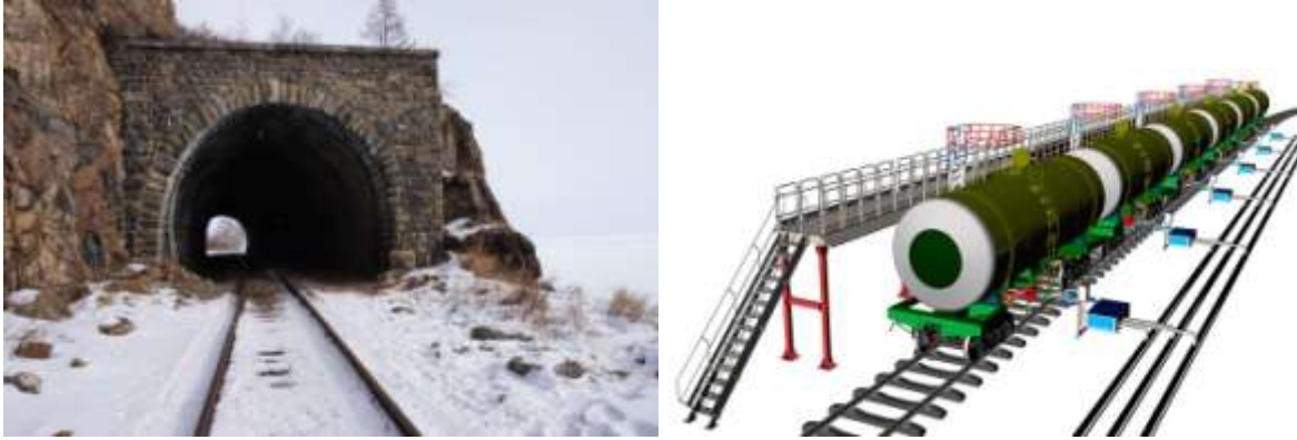
Рис. Тоннель Сливо-наливная эстакада
