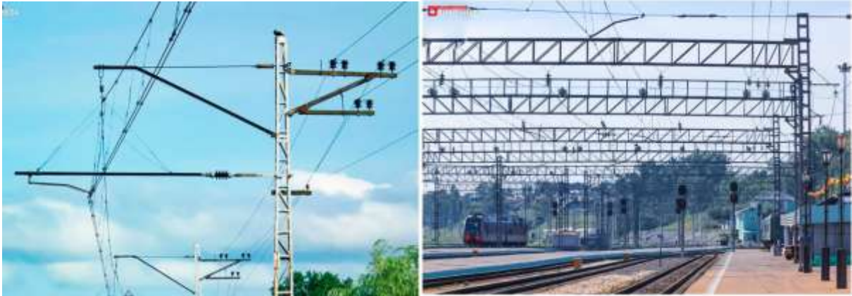
Рис. Контактная сеть
