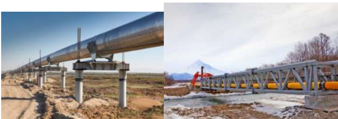
Рис. Трубопровод на опорах и на эстакаде.
