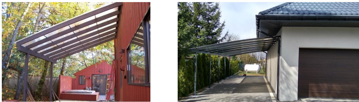
Рис. 19. Навесы, не включаемые в контур здания
