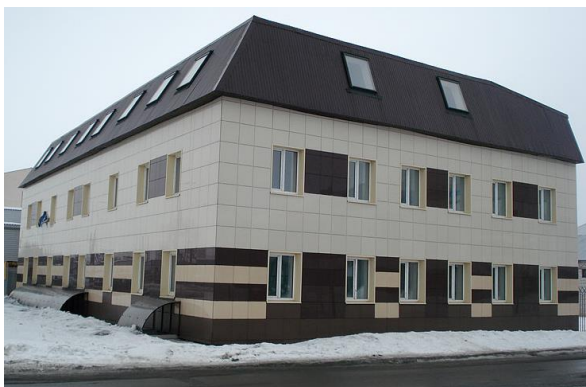
Рис. 18а. Крыша, не включаемая в контур здания
