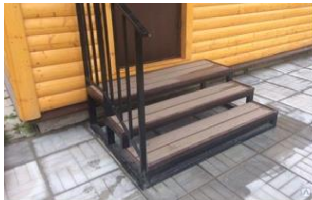
Рис. 17б. Крыльцо, не включаемое в контур здания
